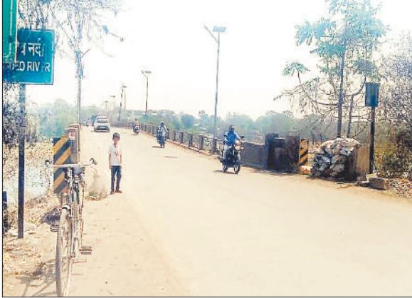
जर्जर हालत में चांपा का गेमन पुल
